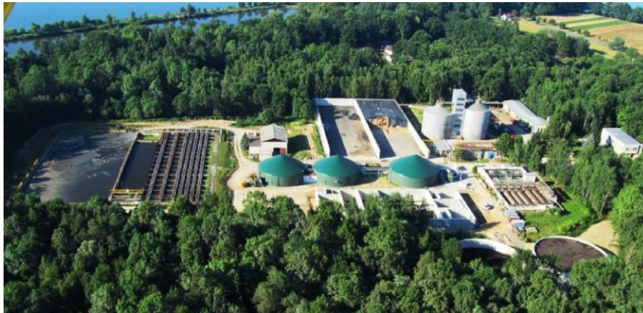
Figura 15. Planta de biogás en Trebon.
